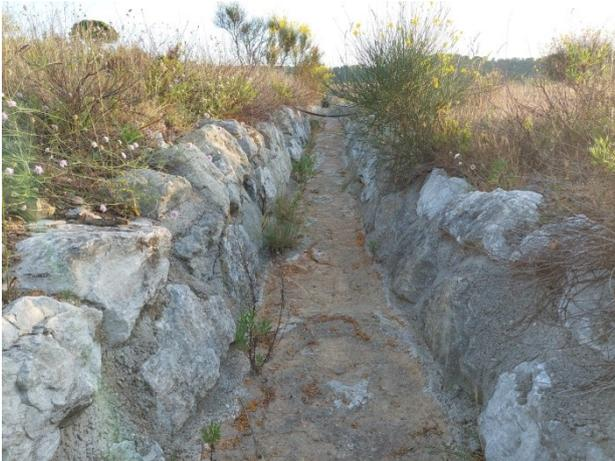
**Photo 59 : Caniveau d'évacuation des eaux pluviales traversant le champ Magné (14/06/22)**
